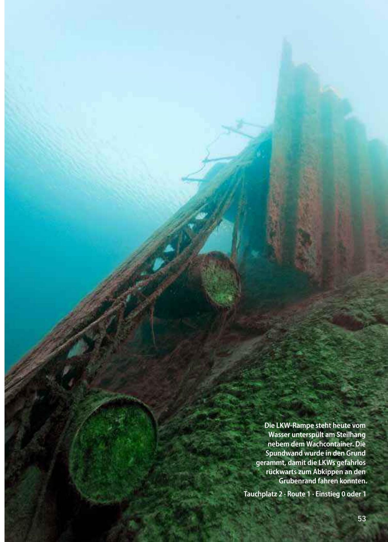
Die LKW-Rampe steht heute vom Wasser unterspült am Steilhang neben dem Wachcontainer. Die Spundwand wurde in den Grund gerammt, damit die LKWs gefahrlos rückwärts zum Abkippen an den Grubenrand fahren konnten.
